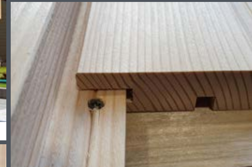
Verdeckte Befestigung
